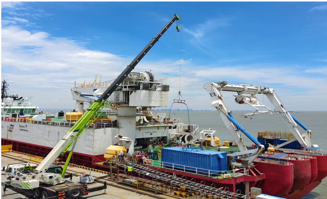
里海海底光缆施工现场
